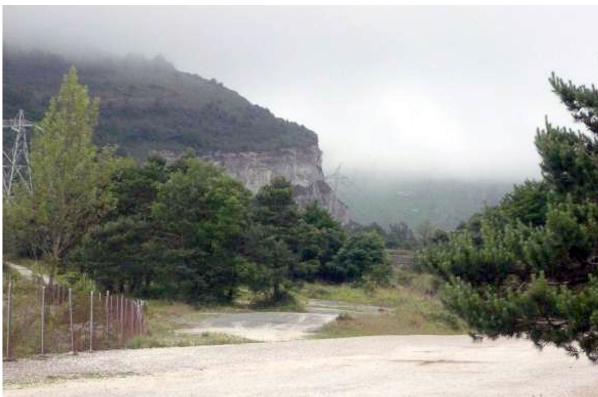
Figura 2. Torres de alta tensión sobre el Collado de puerto de Angulo mirando al Norte
