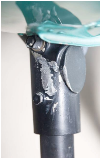
Figura 11. Riostra delantera izquierda
