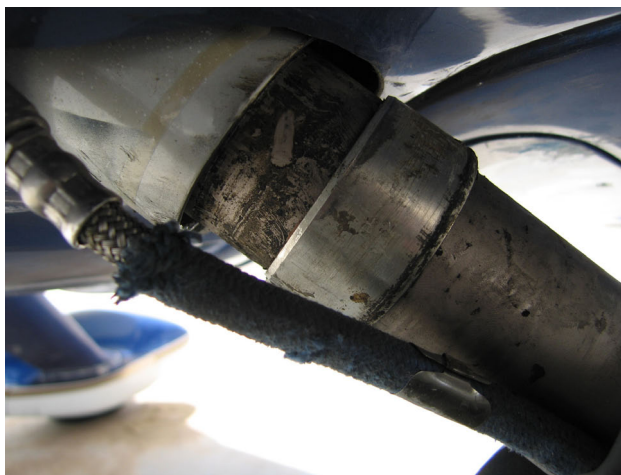
Figura 5. Detalle del casquillo de la pata derecha desplazado de su alojamiento
