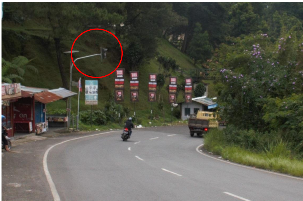
Gambar 37. Warning light dalam kondisi mati dan salah arah
