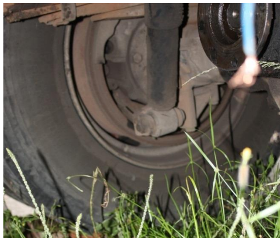
Gambar 18. Tromol roda belakang kanan dan kiri tidak ada penutup
