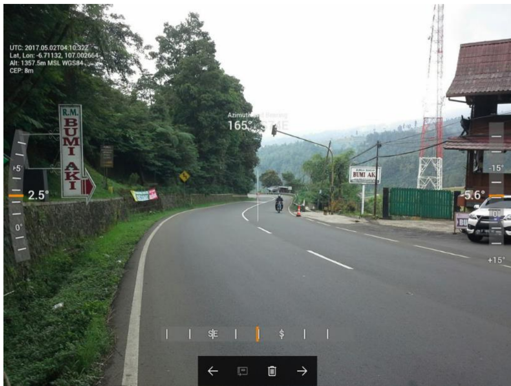
Gambar 48. Kemiringan jalan 50 m sebelum tempat kejadian kecelakaan 9.80 % (5,6°)
