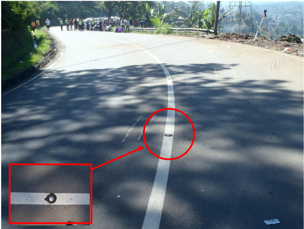
Gambar 36. Marka garis utuh warna putih dilengkapi paku jalan
