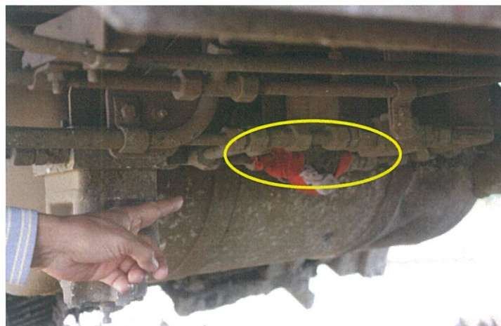
Gambar 5. Magnet valve brake untuk pengereman parkir K3 20705 yang diikat dengan kain
