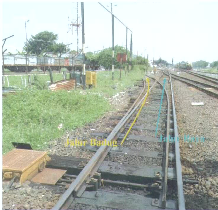
Gambar 6. Wesel dalam kedudukan normal tidak mengarah ke jalur badug tetapi mengarah ke jalur raya
