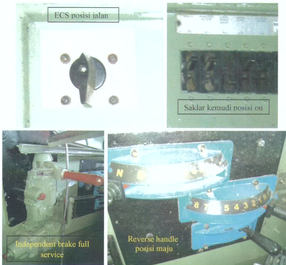
Gambar 4. Posisi peralatan di ruang kabin masinis
