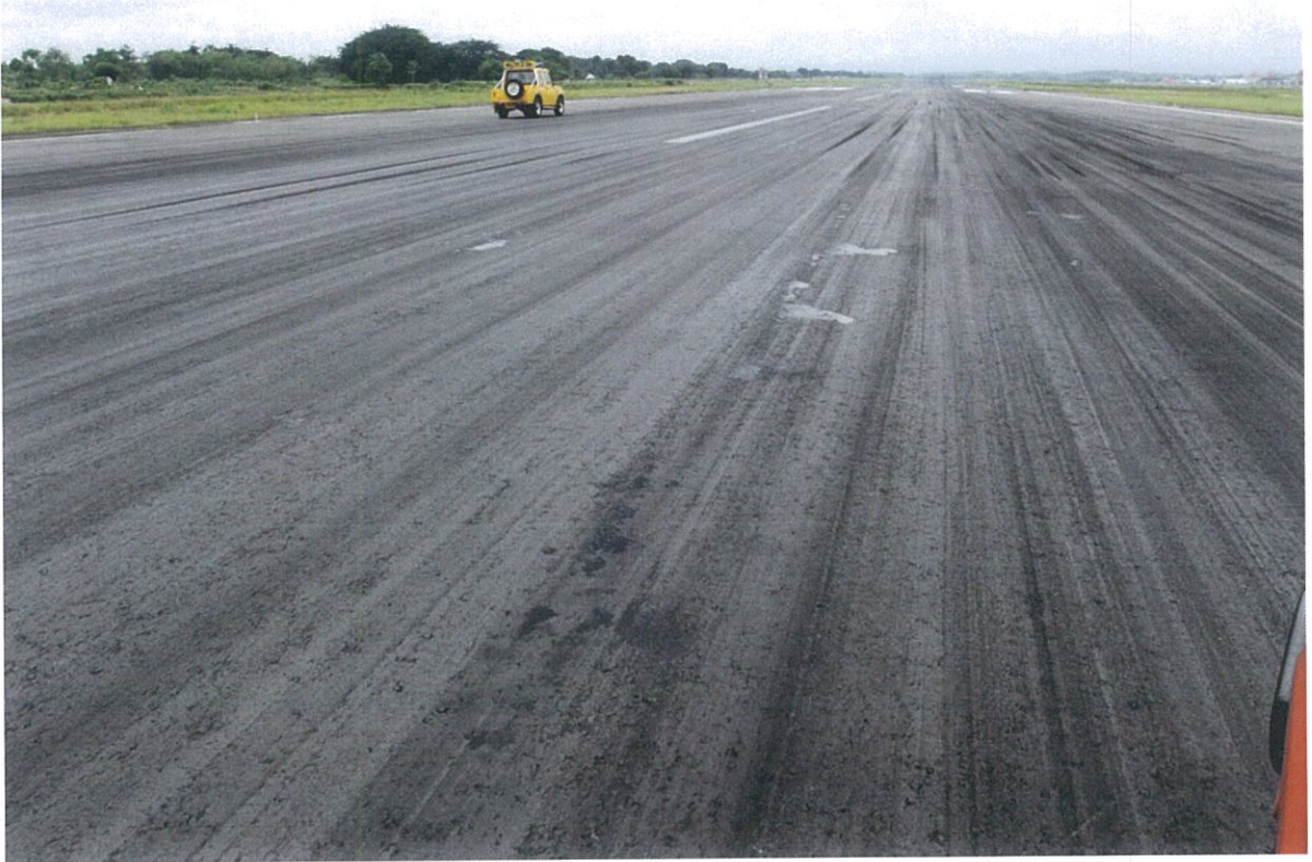
Gambar: Rubber deposit pada runway Bandar Udara Adi Soemarmo
