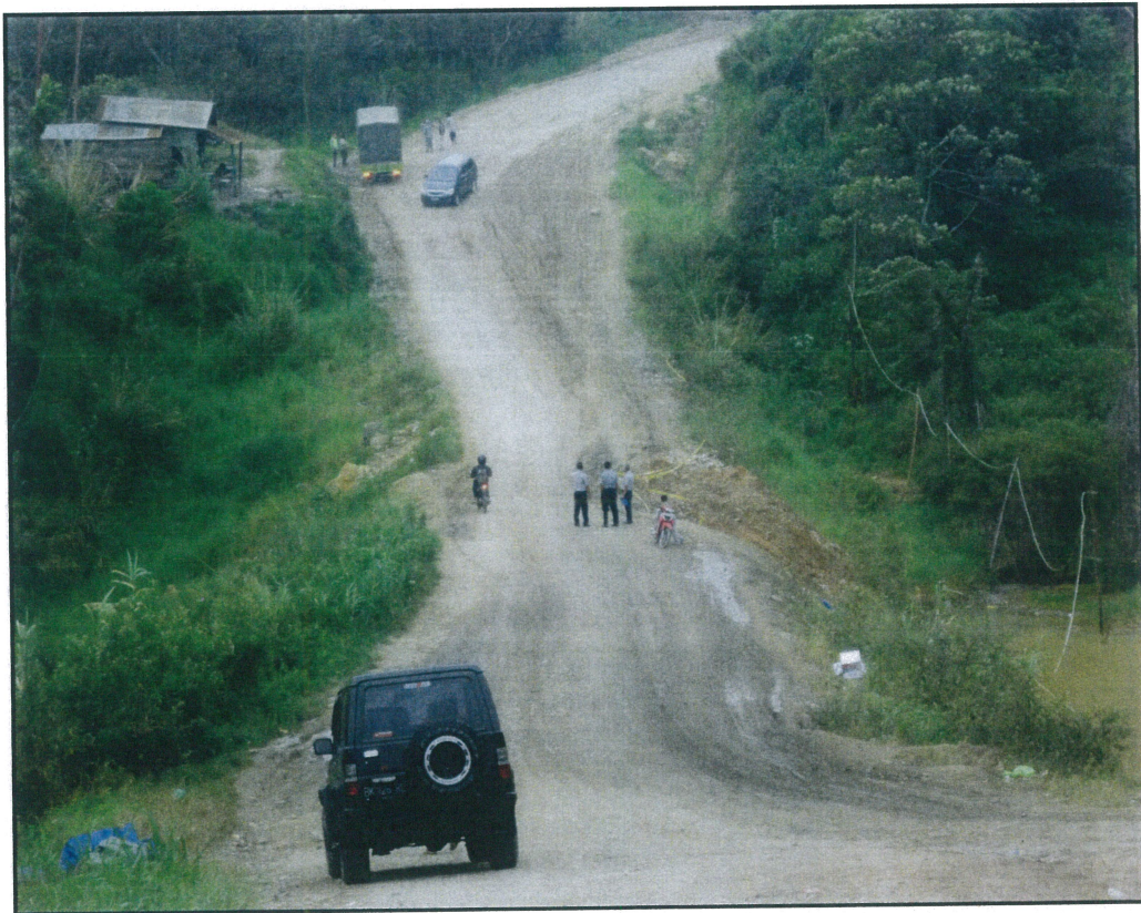
Gambar 1. Kondisi ruas jalan Tarutung – Sipirok Km. 385 dengan kemiringan jalan antara 20° – 30°
