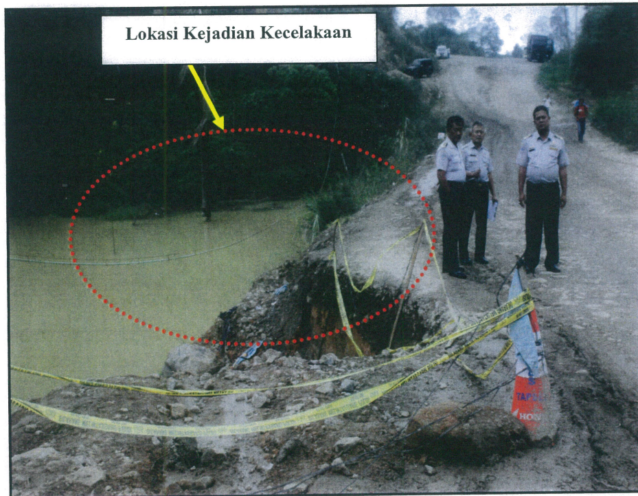
Gambar 2. Lokasi terjadinya kecelakaan
