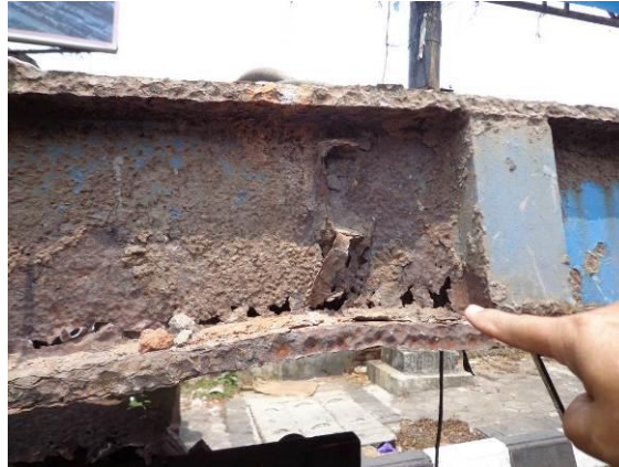
Gambar 8. Kondisi rangka landasan kereta tempelan.
