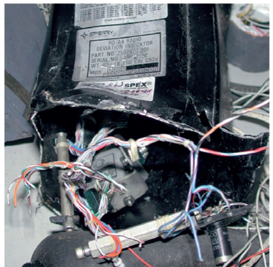
Foto n. 25: HSI destro S/N 81114723.
