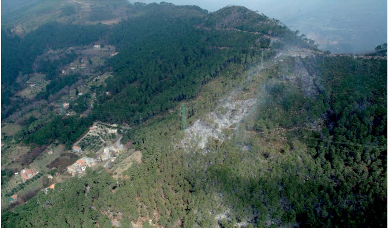
Foto n. 4: in primo piano la linea n. 550, con il traliccio 42. Notare il colore verde dei tralicci.
