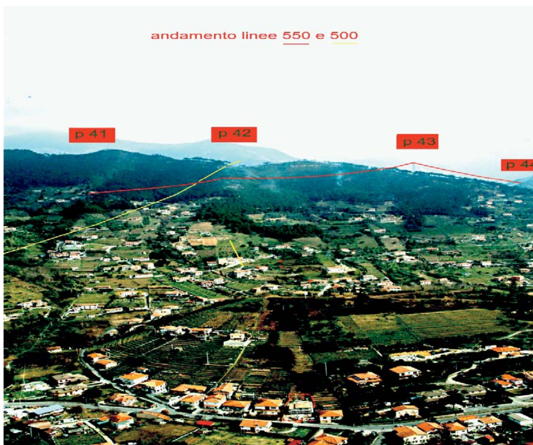
Foto n. 19: notare la posizione del traliccio n. 42.
