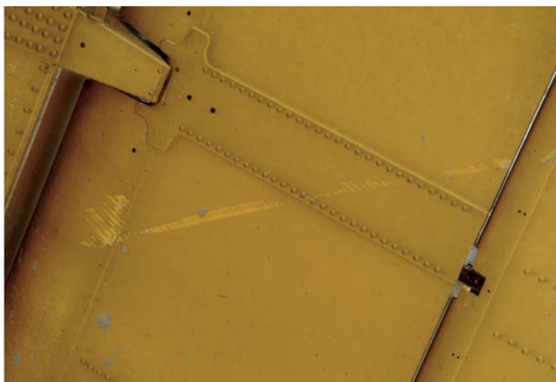
Foto n. 7: sfregamento del cavo di guardia.
