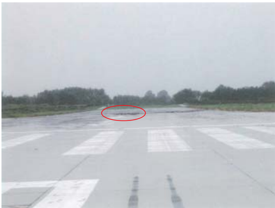
Parte finale della pista. La fotografia è stata fatta in direzione 25 con evidenziata la freccia posizionata non correttamente
