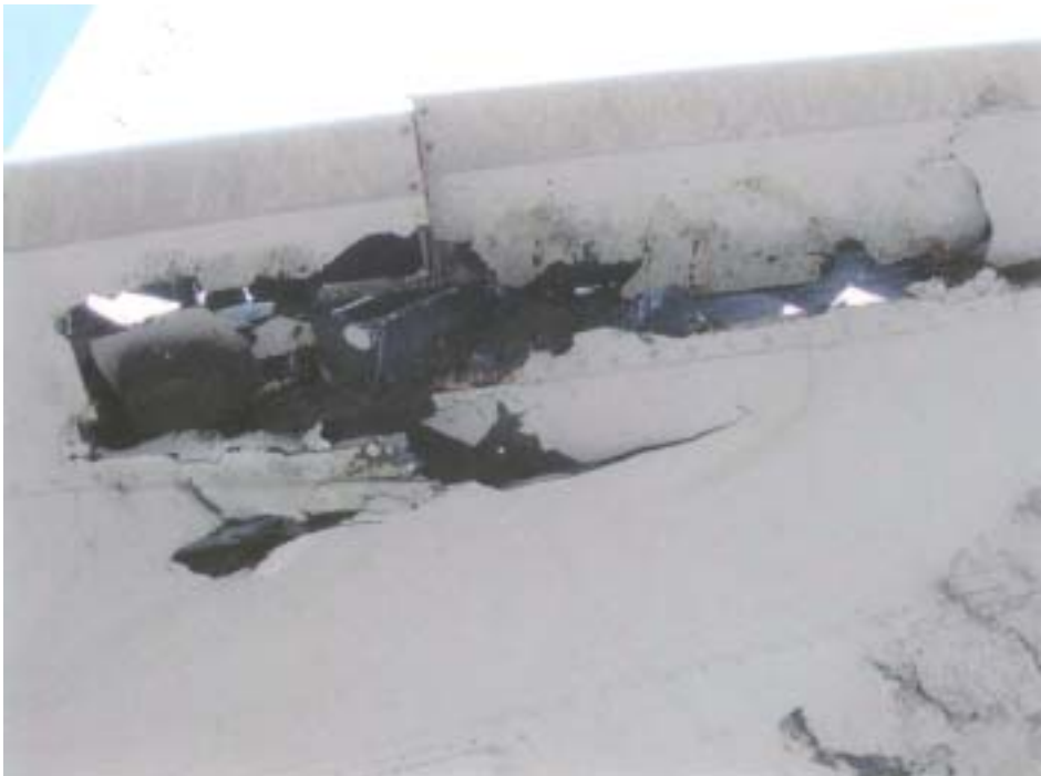
Danni dell'aeromobile; particolare stabilizzatore sinistro
