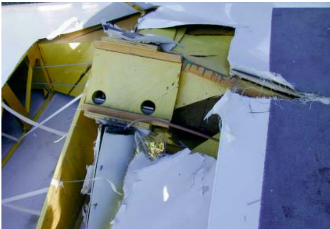
Particolare danni cassone alare dopo rimozione rivestimento
