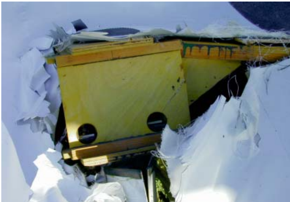
Danno cassone alare SX. Vista dall'alto (particolare)
