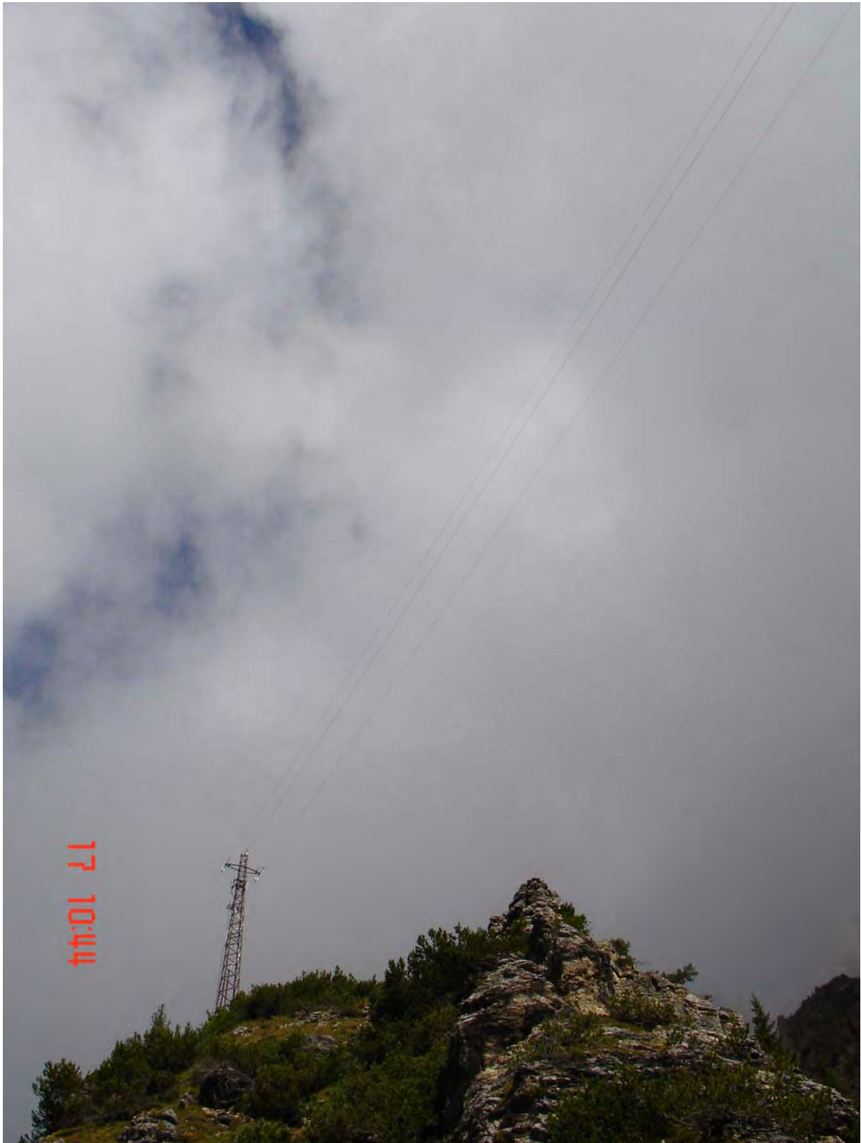
Foto 9: tratto linea elettrica ripristinato dopo l'incidente.
