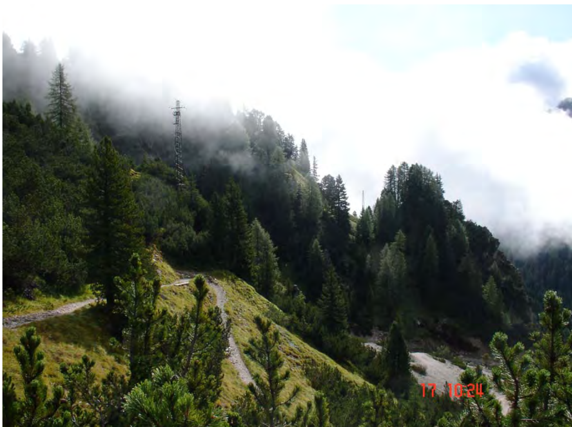
Foto 8: tratto linea elettrica ripristinato dopo l'incidente.
