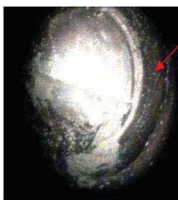
Particolare del materiale ostruttivo.
