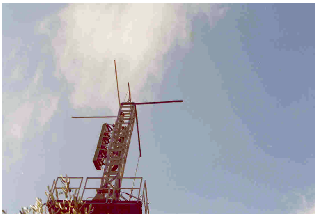
Particolare sommità traliccio con barre parafulmini
