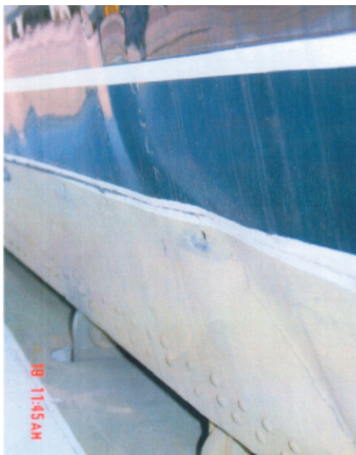
Notare il corrugamento della struttura.
