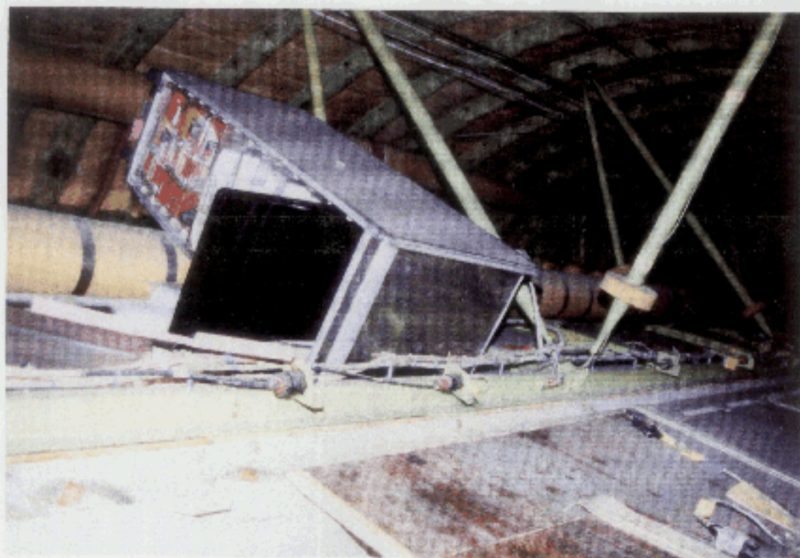
左側通路座席46付近の天井から後方を見る
