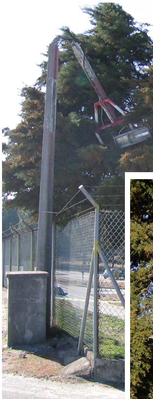
Figs. 5 e 6 – Os danos verificados no poste de iluminação e na copa da árvore onde a aeronave embateu.
