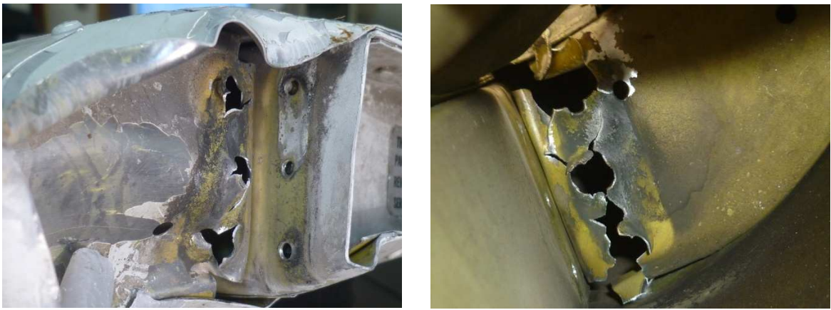
Fig. 11 – Dois exemplos de esforços de corte devido a arrancamento na vizinhança dos rebites das zonas de fixação do flap
