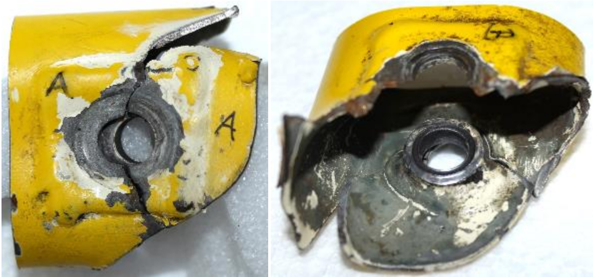
Obr. 3 Přehledové snímky vzájemné polohy protikusů porušené vzpěry u otvoru A.
