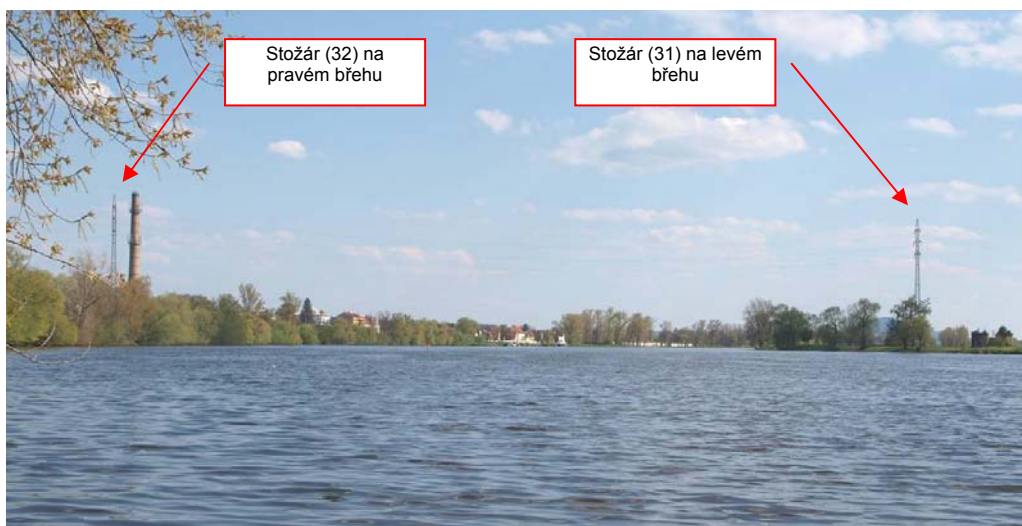
Obrázek č. 1 Pohled ve směru letu na vedení na stožárech na pravém (32) a levém břehu (31).
