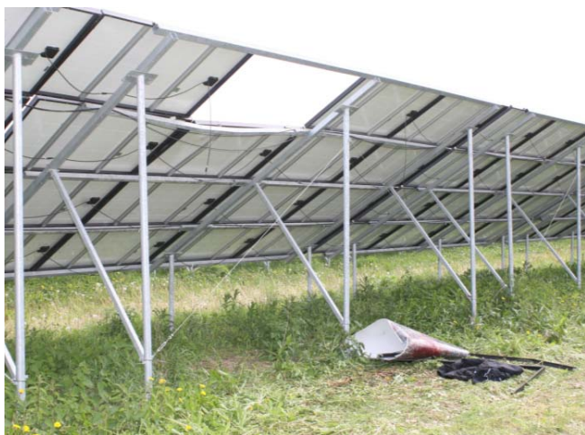
Místo dopadu na konstrukci panelů a detail solárního panelu po nárazu
